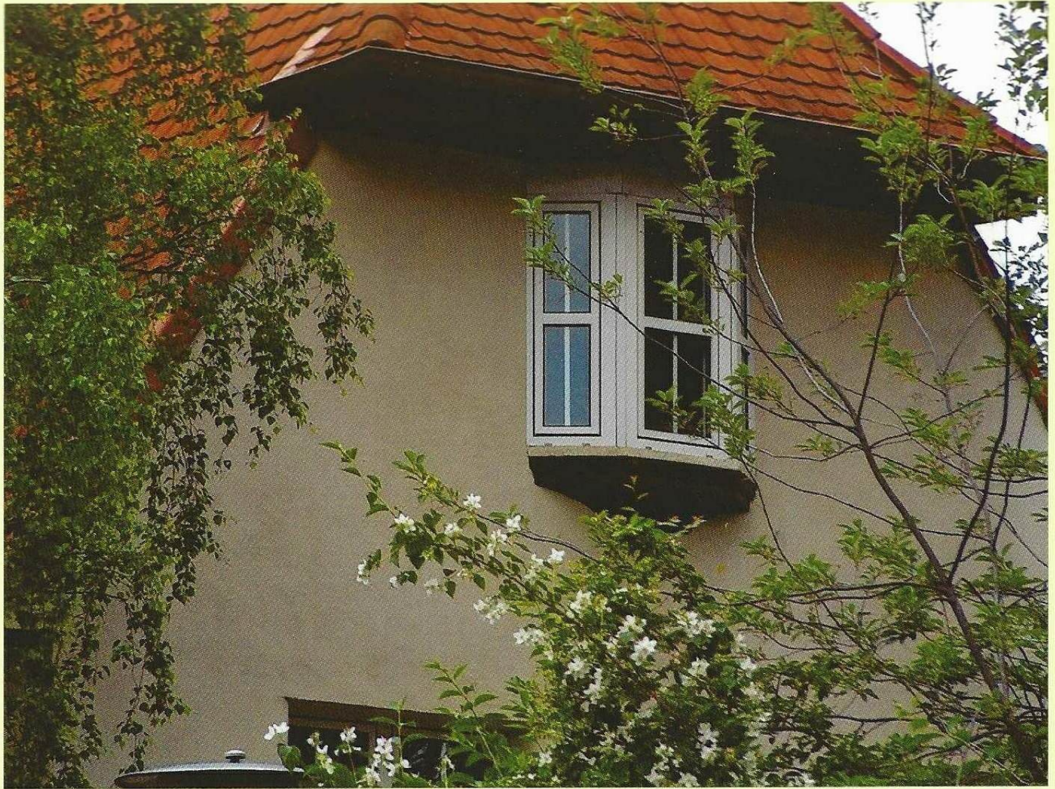
Eckhaus im Dohnaweg
