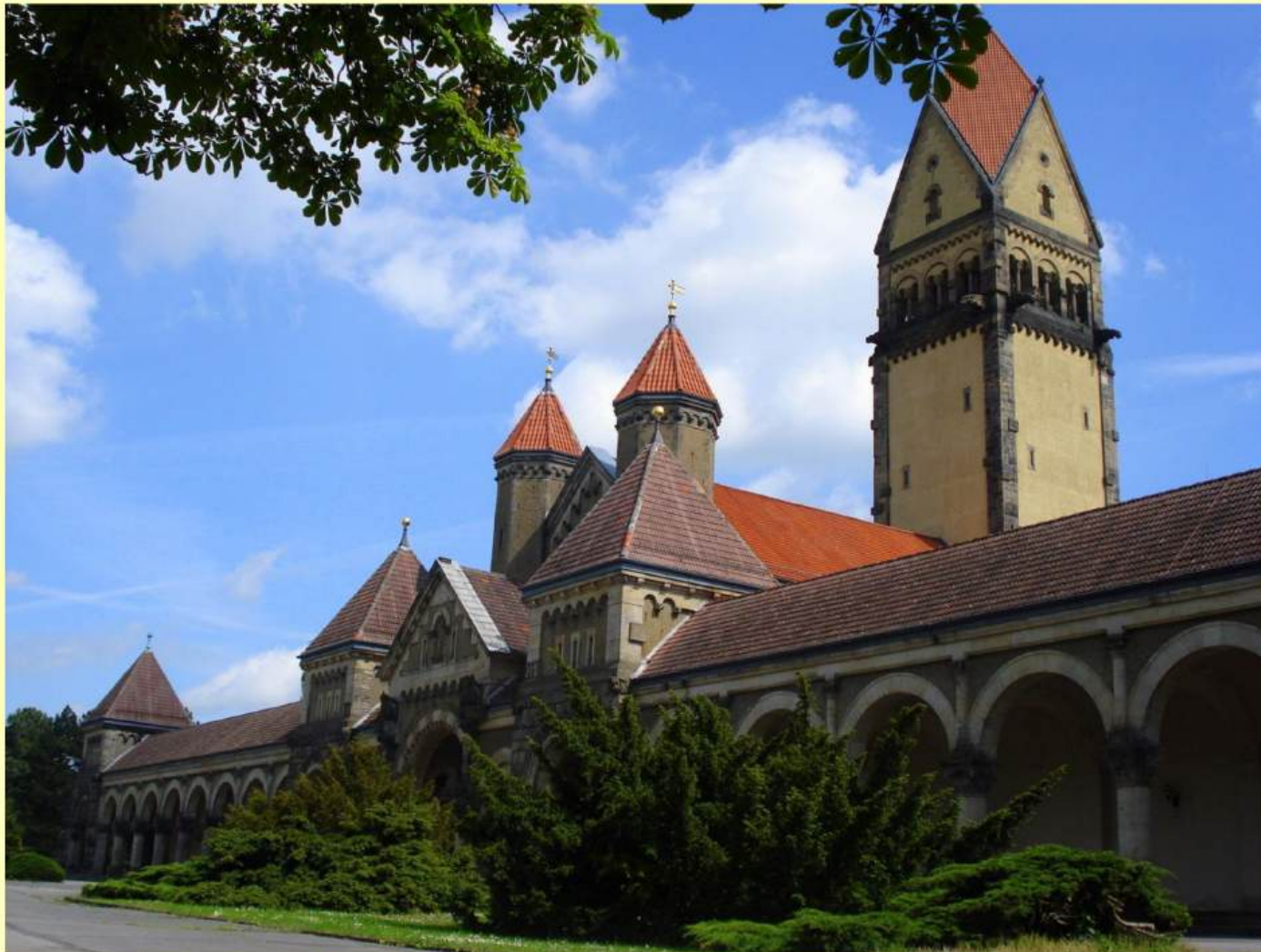
Krematorium Südfriedhof - Foto: Tobias Weichert
