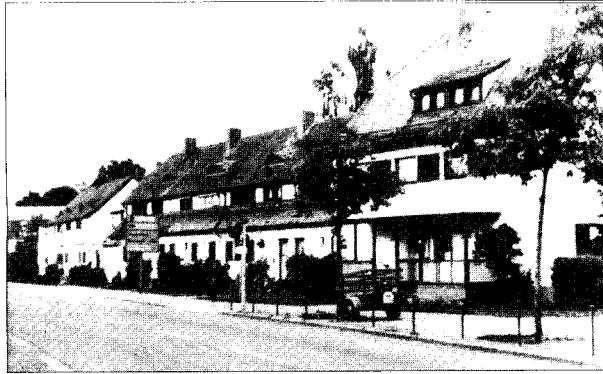
Straßenansicht Finkenbrunn Nr. 15-29 (Zustand 1986)
