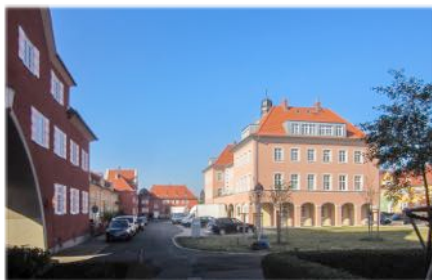
Zentralgebäude, früher Kaufhaus und örtliches Zentrum, heute zu Wohnungen umgenutzt
