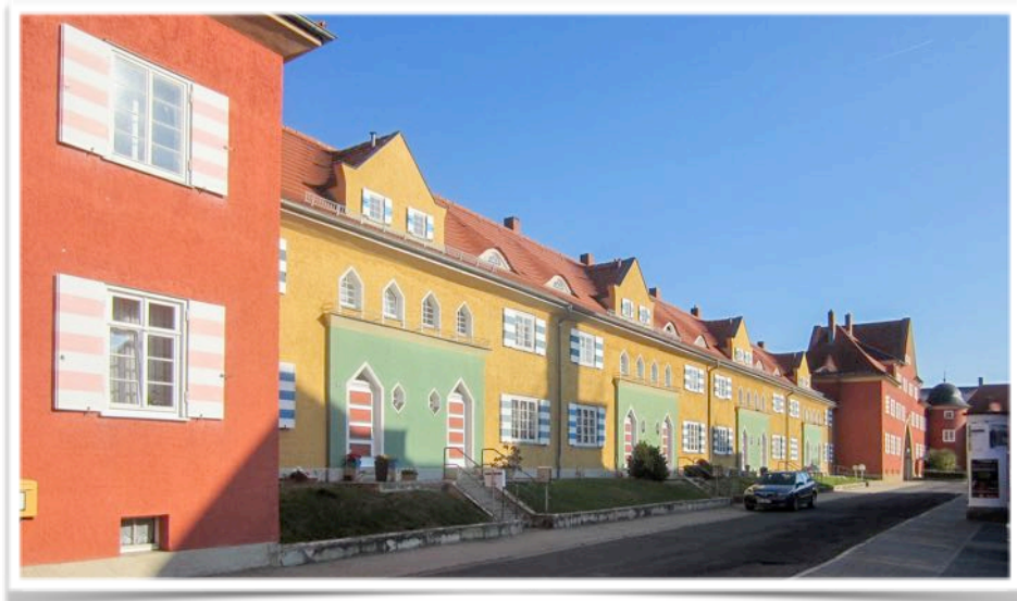
Eine der beiden Querriegel mit Durchfahrten zum dahinterliegenden Halbkreisabschnitt
