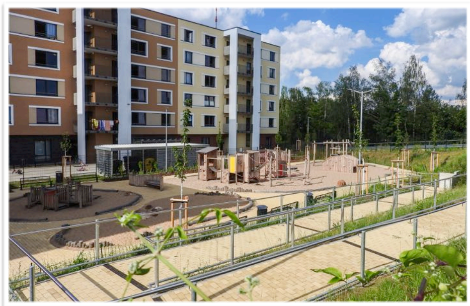
Fertiggestellter Spielplatz, kurz vor der Abnahme und öffentlichen Inbetriebnahme
