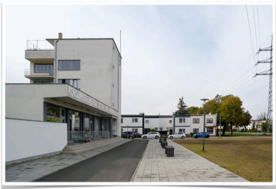
Das Konsumgebäude als Wohngebietszentrum am Knickpunkt der Hochspannungsleitung Am Dreieck 1, Blick von der Damaschkestraße
