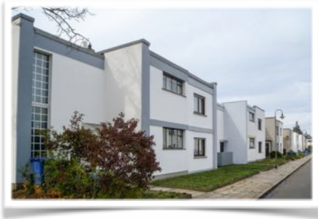
Haustyp SieTö II Kleinring, Gebäudeflucht, Westseite
