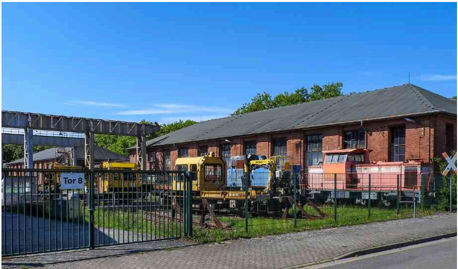
Heute in denkmalgeschützten Hallen: Moderner Betrieb zur Wartung von Gleisbautechnik. (Foto: Ronald Börner)
