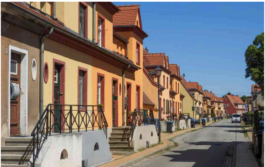
Kirchmöser-Ost heute: Abwechslungsreiche Fassaden innerhalb der Grenzstraße, fast alle vorbildlich saniert. (Foto: Ronald Börner)
